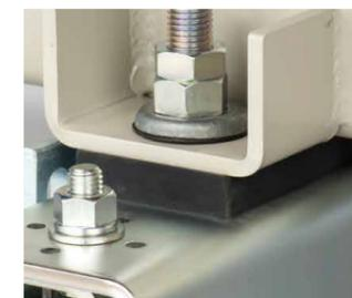
変圧器の運転時の振動が床へ伝わるのを低減します。
